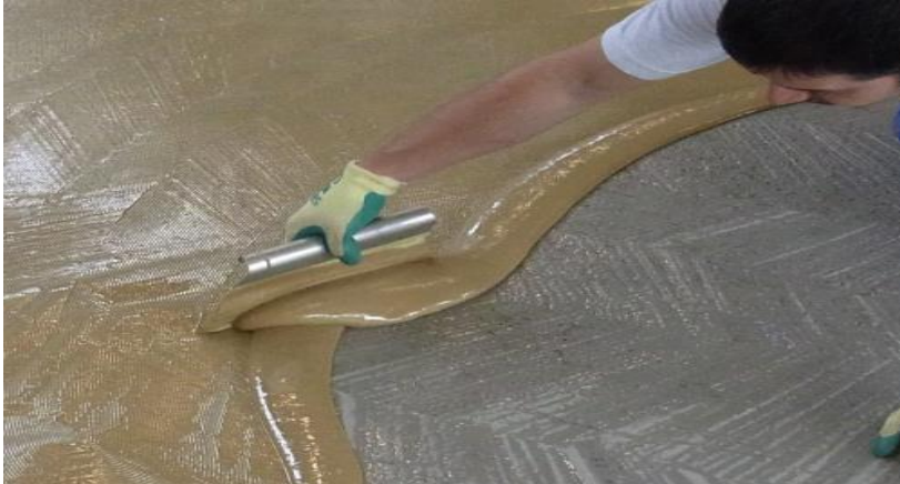
Figura 2: Aplicación del pegamento sobre la base
