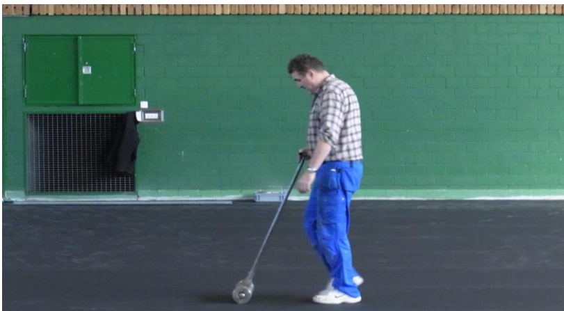
Figura 4: Apretar el recubrimiento elástico
