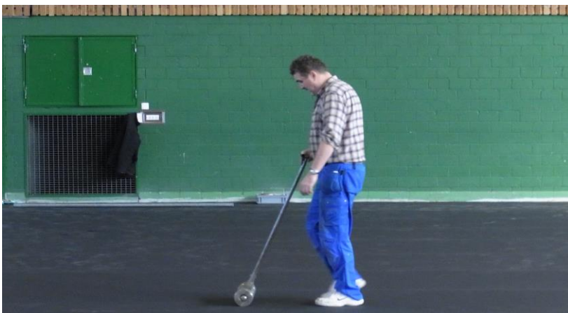
Figura 4: Apretar el recubrimiento elástico
