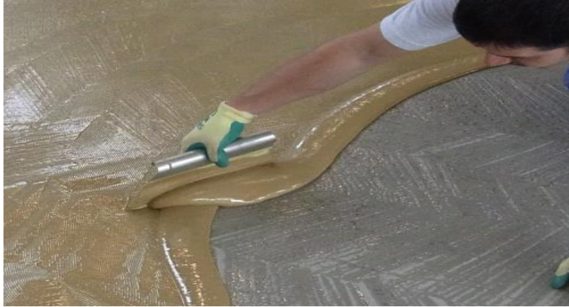
Figura 2: Aplicación del pegamento sobre la base
